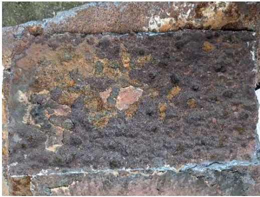
圖 3 實船回港檢驗後更換下來的舊板。 Figure 3 Corroded steel plate from real ship.
