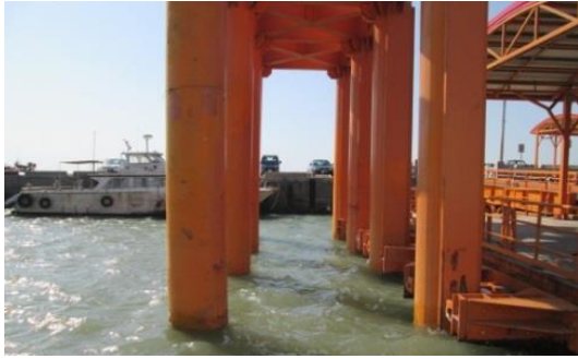
圖 3 浮動碼頭鋼管樁。 Figure 3 Floating-box dock of steel piles.
