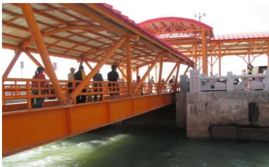
圖 5 浮動碼頭聯絡橋。 Figure 5 Floating-box dock contact bridge.
