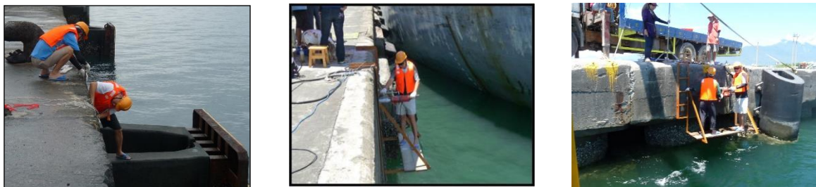
圖 5 非破壞性檢測現地作業情形。 Figure 5 Non-destructive testing in-site operation.
