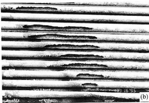
圖 6 民國八十四年破損管取樣外觀 Fig. 6 Morphology of tubes failed in 1995
