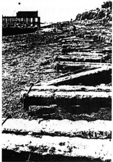
(2b) 置放於海灘上之混凝土試體
