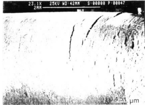
照片七 試片 N8之表面觀察 Photo. 7 Surface cracks of N8 specimen.
