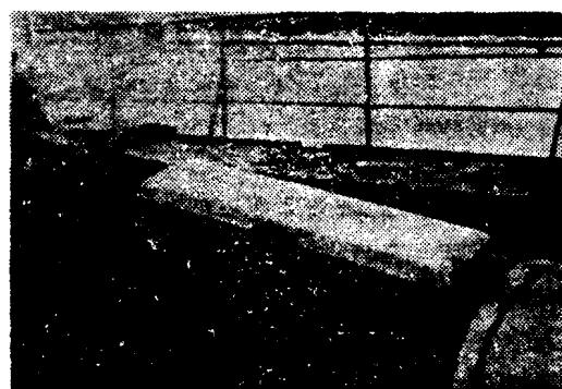
照片 3 板狀鋁合金陽極焊接於管上
